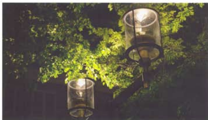
Lanternen er monteret på master med en dobbeltarm og bestykket med 32 W kompaktlystofrør. Foto: Mikael Silkeberg.
